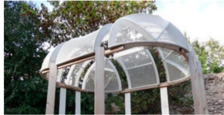
le baldaquin réalisé avec les modules c1 et c2 en agglo hydréfuge, peinture acrylique ext. recouvert d'une toile de tarlatane
